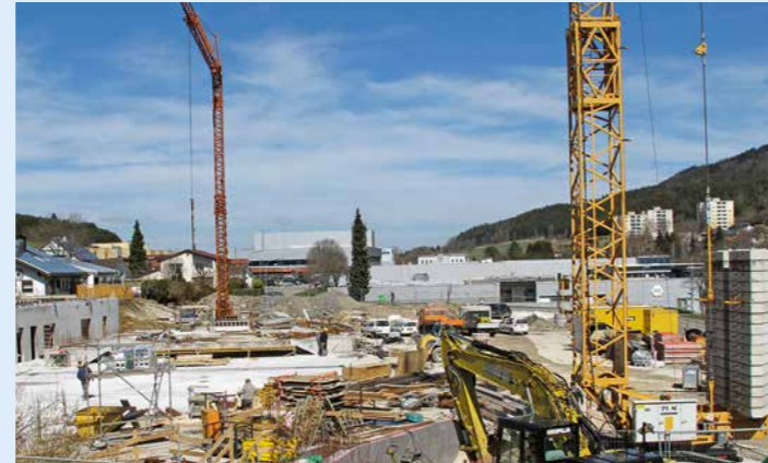
Neubau der Schlossberghalle Wehingen
