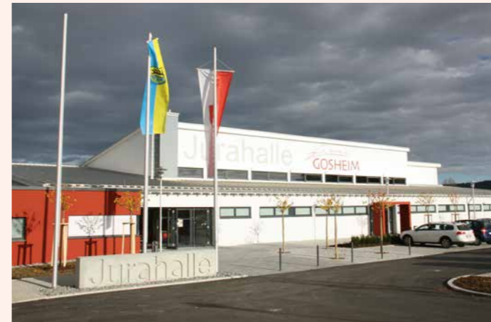
Einweihung der generalsanierten Jurahalle.
