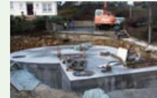
Eines der fünf dezentralen Regenrückhaltebecken im Bau befindlich. Heute fährt der Verkehr wieder darüber. Außer zwei Schachtabdeckungen ist im Straßenraum nichts mehr zu sehen.
